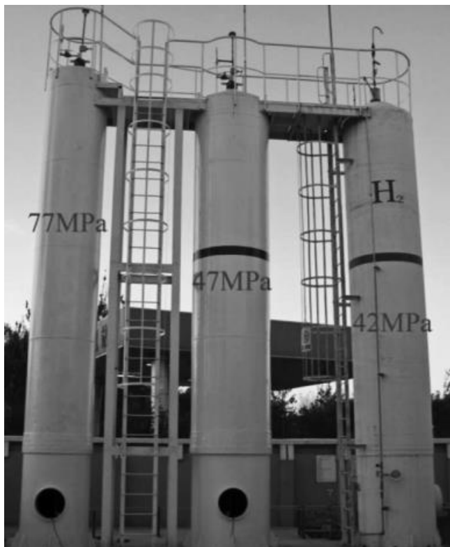
Figura 8 Recipientes estacionarios multifuncionales de hidrógeno
